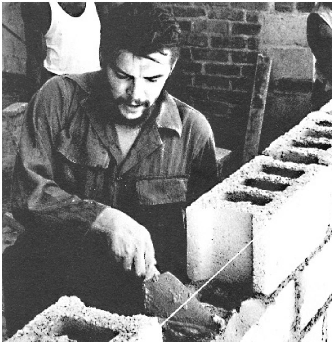
Frivilligt arbete på en byggarbetsplats för en ny skola 1960.
